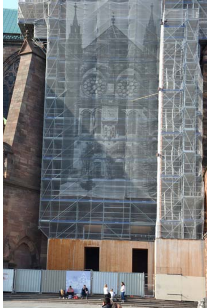
Gegenwärtig ist die Sanierung der Südfassade des südlichen Querhauses im Gange.
